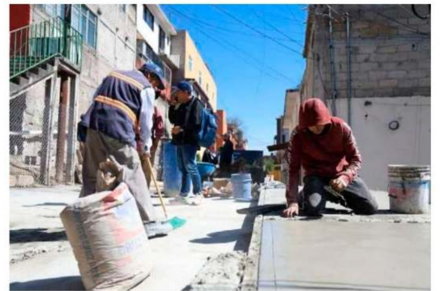
Arreglan la infraestructura urbana.
