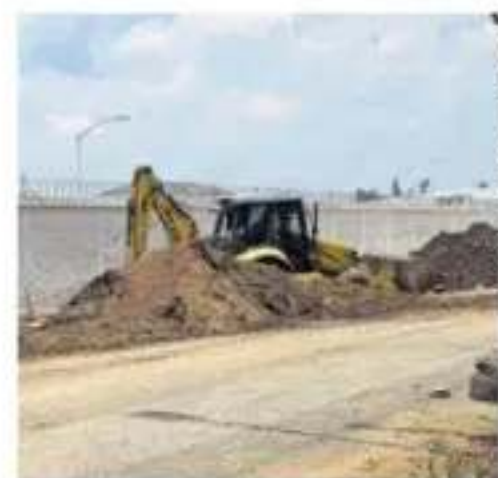
La maquinaria trabaja en el ducto donde se detectó la fuga.
