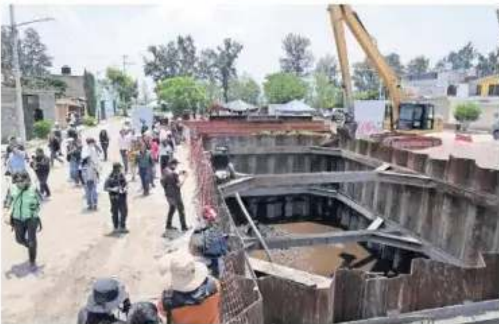
Entre las obras de mitigación en San José, Tláhuac, destacan la rehabilitación de plantas de bombeo.
