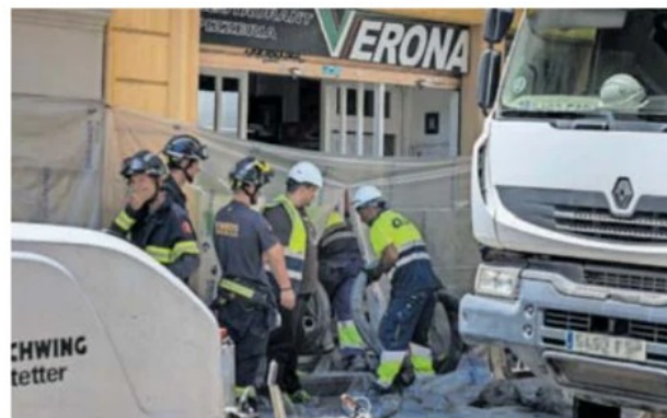
Uno de los inmuebles afectados por el socavón. GIANLUCA BATTISTA
