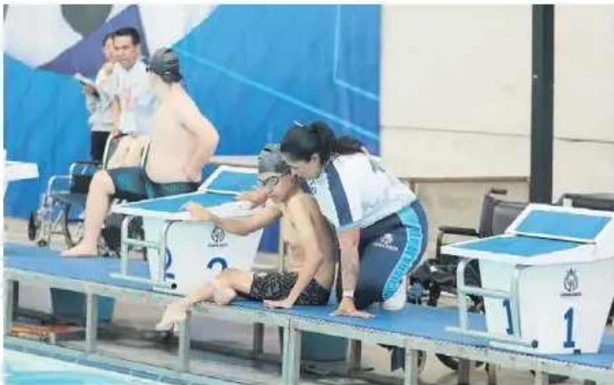
Familiares señalan que esta estructura elevada es un peligro para los atletas con movilidad reducida. / Gerardo García
