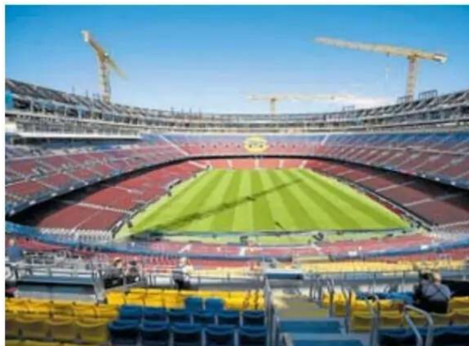
Obras en el estadio del Fútbol Club Barcelona. ABC
