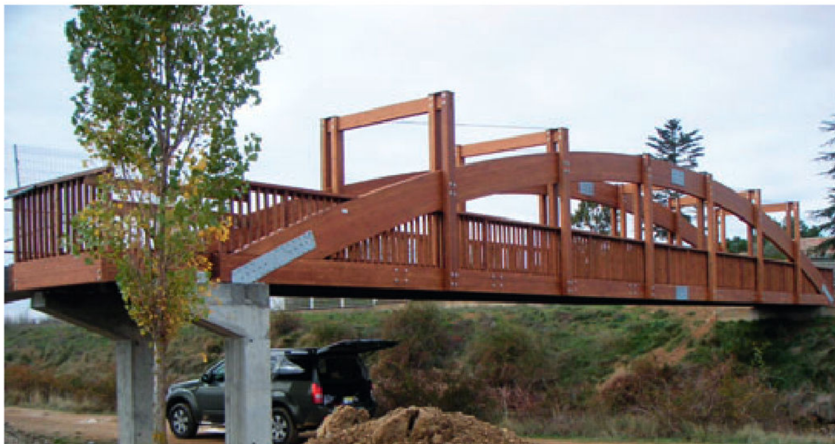
El uso de madera estructural cobra cada vez más fuerza.
