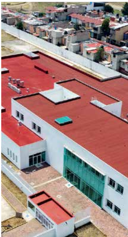
HOSPITAL MUNICIPAL. Después de 14 años de abandono, se retomó la habilitación de esta obra.
